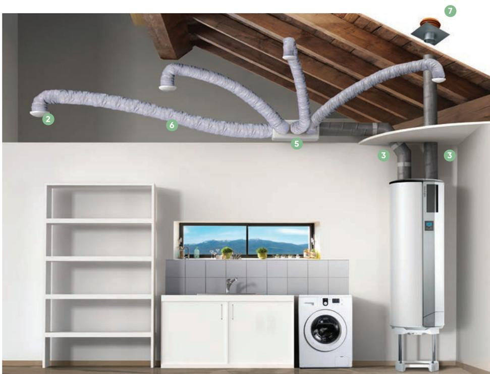
Réseau pieuvre en volume non chauffé (le réseau d'extraction doit impérativement être isolé thermiquement).
